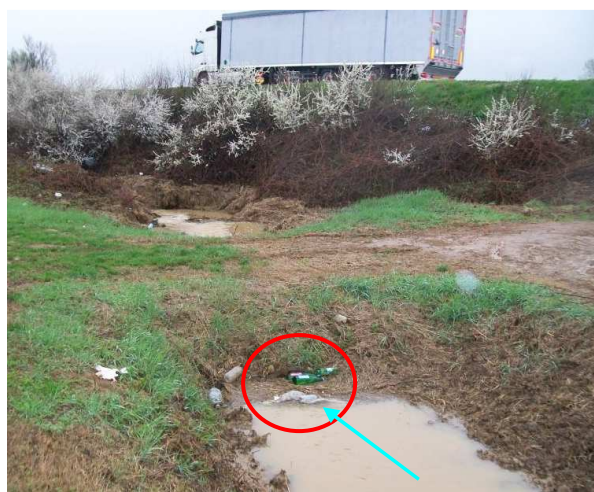
FOTO 2 PROBLEMI DI DEFLUSSO NELLA TUBAZIONE INTERRATA PRIMA DEL SOTTOPASSO RILEVATO DOPO UN EVENTO METEORICO
