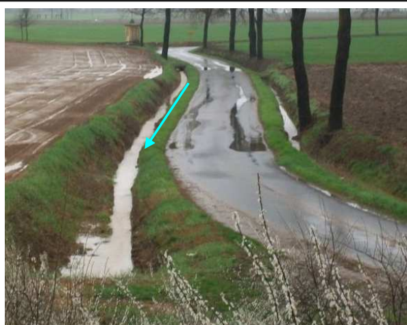
FOTO 3 PROBLEMI DI DEFLUSSO A MONTE DEL SOTTOPASSO DOPO UN EVENTO METEORICO
